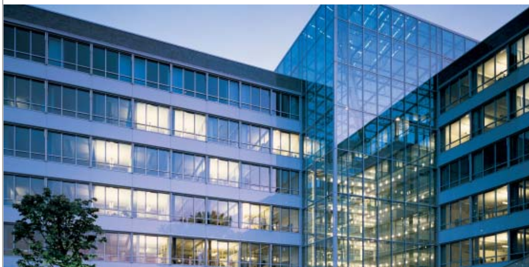
Die Zentrale der VR-LEASING AG in Eschborn
